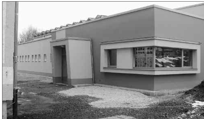
Außenansicht Westseite des Sport- und Gemeindezentrums
