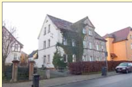
Eingangsbereich zum ehemaligen Postamt.
