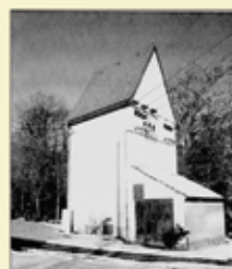
Transformatorhaus in der Friedensstraße
