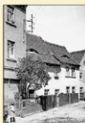
Leitungen an der Hauswand
