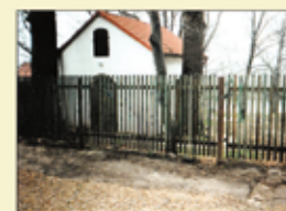
Druckerhöhungsanlage im Bornholz
