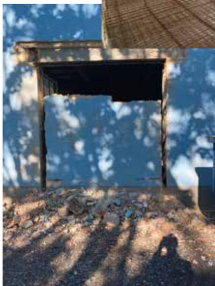
Insbesondere beim Rohbau (Rückbau der Fußbodenbetonplatte) musste von der ursprünglichen Planung abgewichen werden, um effizient voranzukommen. Dazu wurde in der Giebelseite eine Öffnung hergestellt, damit mit schwerem Gerät in die Halle eingefahren werden konnte.
