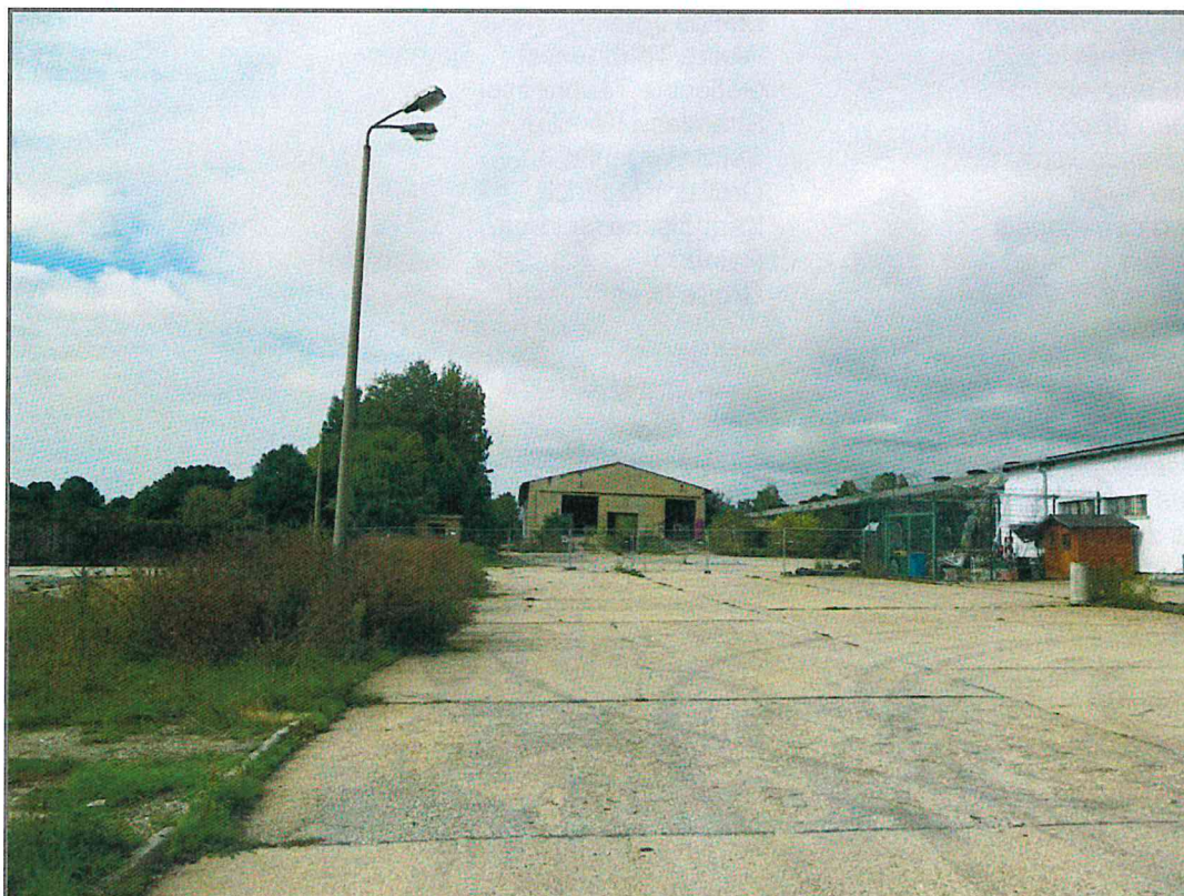
Foto 1 Westlicher Teilbereich des Geltungsbereichs
