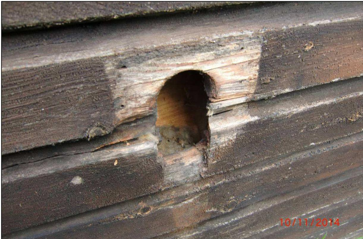
Abb. 4: Fassadenschaden an Bungalow 4 - Dämmung vorhanden
