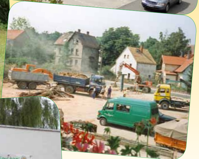
oben: Droyßig, Zeitzer Straße 15, 2014 unten: Abriss KFL Droyßig 1994
