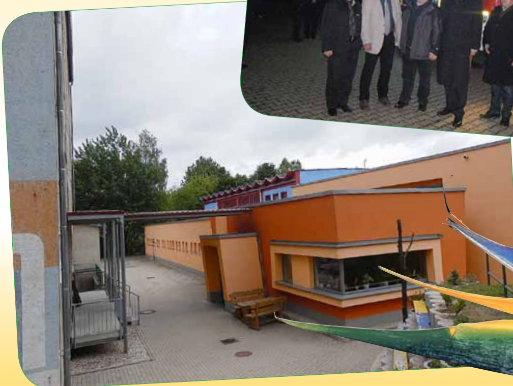
Gutenborn - Anbau an Gemeindezentrum Droßdorf
