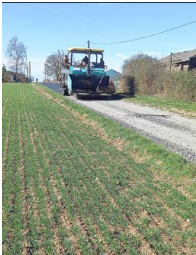
Straße alte BHG Asphaltdecke
