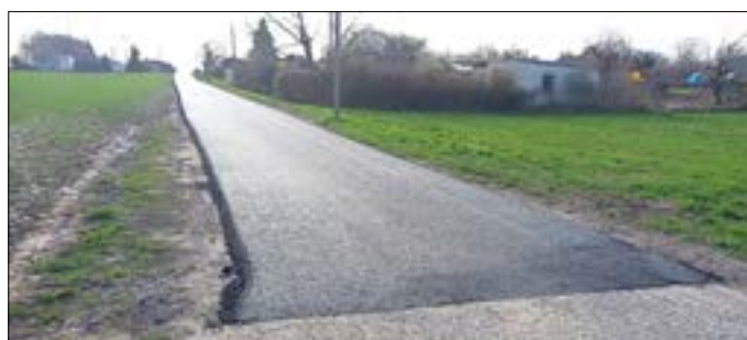
Straße alte BHG Asphaltdecke
