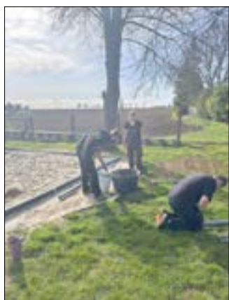
- Pfosten für Sonnenschutz einzementieren
